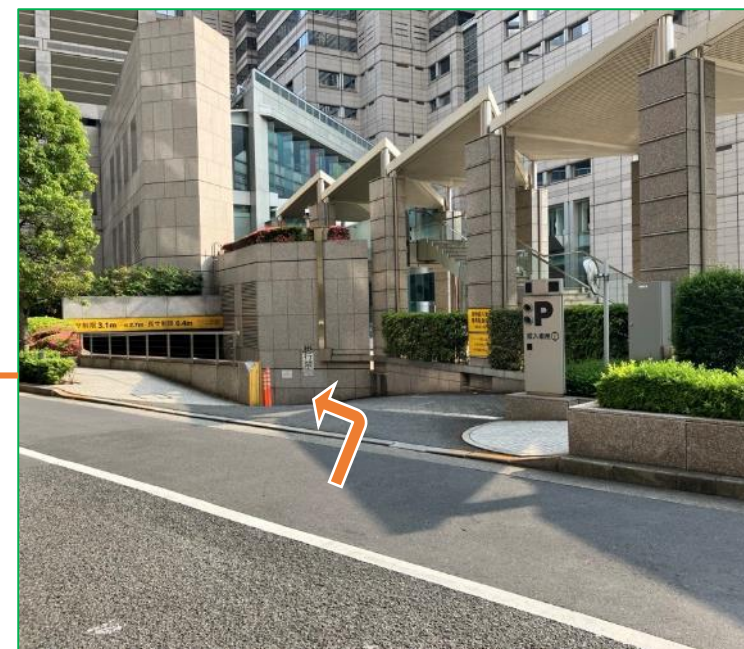
↑ 搬出入駐車場出入口
